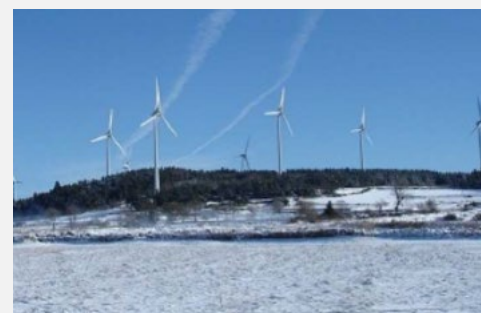
Parc de SAINT JEAN LACHALM Département : Haute-Loire (43) Puissance électrique : 18MW 9 éoliennes Mise en service : 2008
